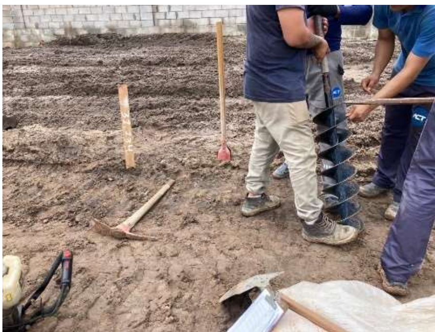
Figura 5 - Ato de sondagem in loco.
