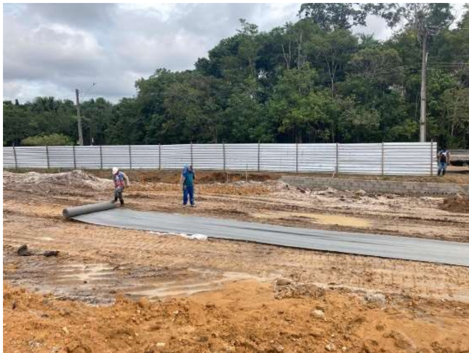
Figura 8 – Execução do procedimento.
