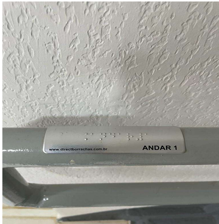
Figura 9 – Detalhe da placa no corrimão.
