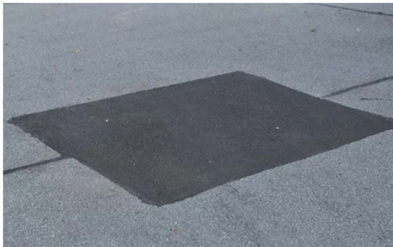
Figura 9 - Remendo em pavimentos
