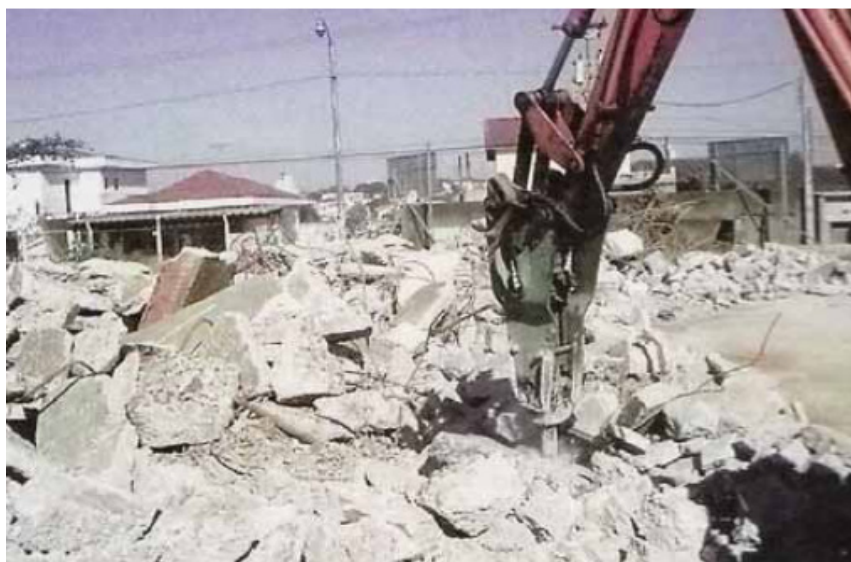
Figura 3 - Demolição do piso existente no terreno da Obra do condomínio Villaggio Maia.
