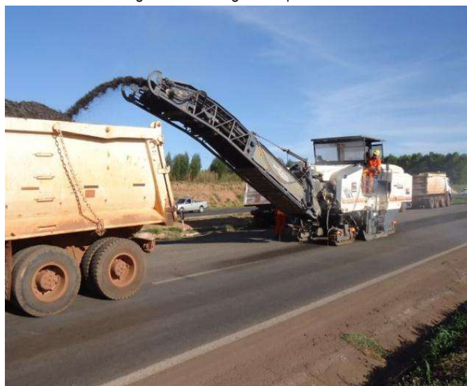
Figura 7 - Fresagem do pavimento
