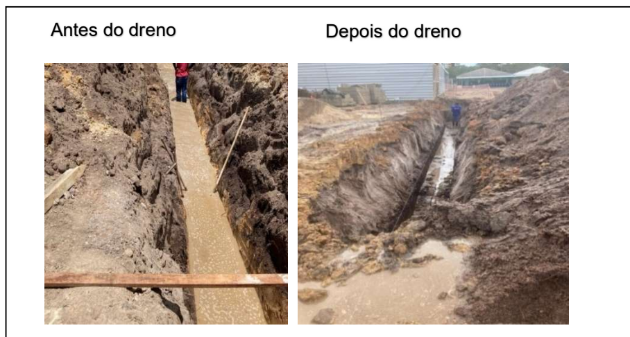
Quadro 1 - Drenagem no mesmo trecho, antes e pós dreno.
