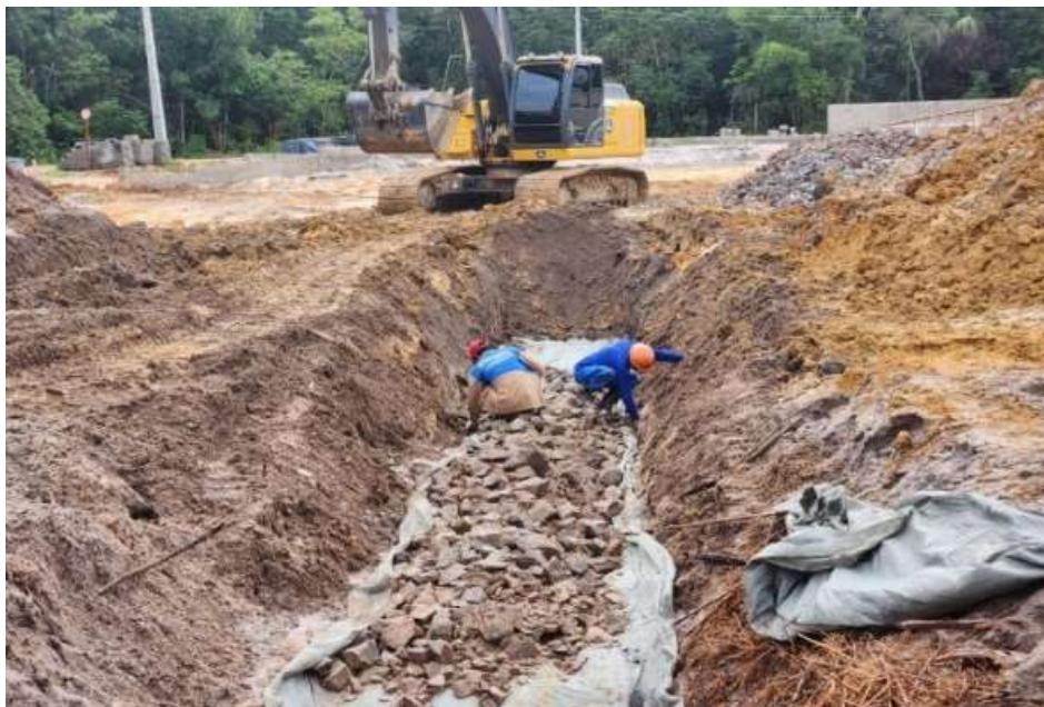
Figura 10 – Colocação pedra rachão no dreno.
