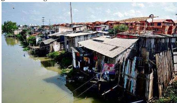
Figura 33 – Margem do Canal do Tucunduba, bairro do Guamá
