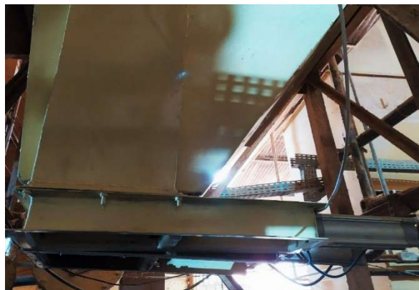
Figura 3 - Registro de dosagem de ingrediente.
