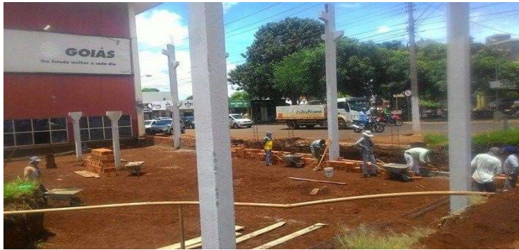
Figura 1 - Estruturas de pré-moldados.
