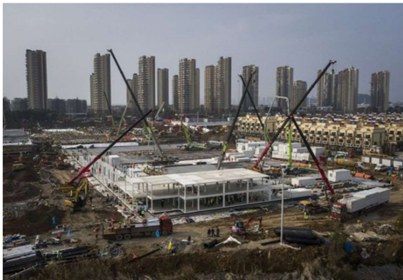
Figura 4 - Início da Construção em Wuhan, China.
