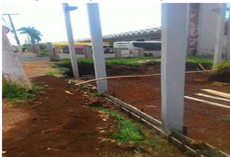
Figura 2 - Pilares pré-moldados da superestrutura.
