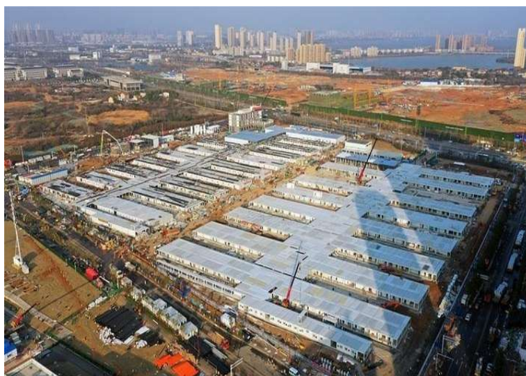
Figura 6 – Construção do hospital Leishenshan.
