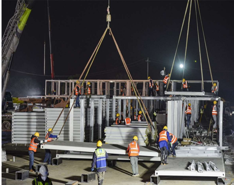
Figura 5 - Operários instalam peças pré-fabricadas para montar os módulos do hospital Huoshenshan em Wuhan, na China.
