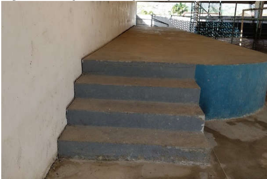
Figura 47: Escada que dá acesso ao palco da quadra do bairro Jacobina II
