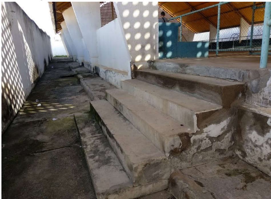
Figura 45: Acesso 2 por escada da quadra do bairro Jacobina II
