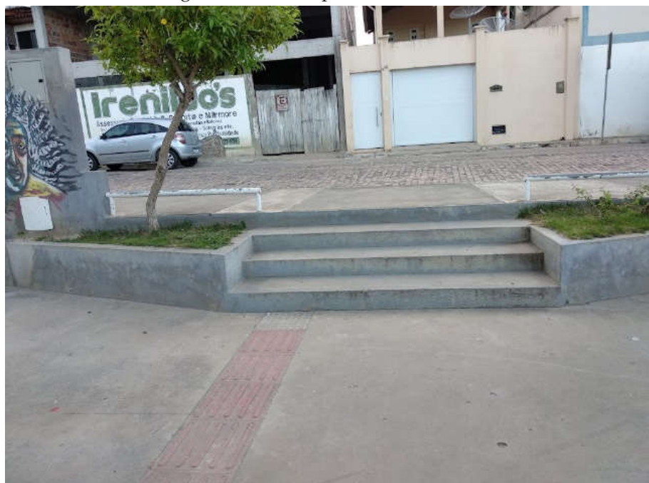
Figura 51: Escada que dá acesso ao CEU
