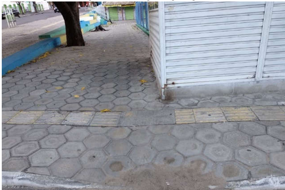
Figura 21: Rampa de acesso da quadra poliesportiva do centro
