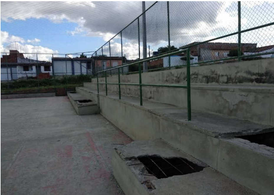
Figura 37: Arquibancada da quadra do bairro Catuaba
