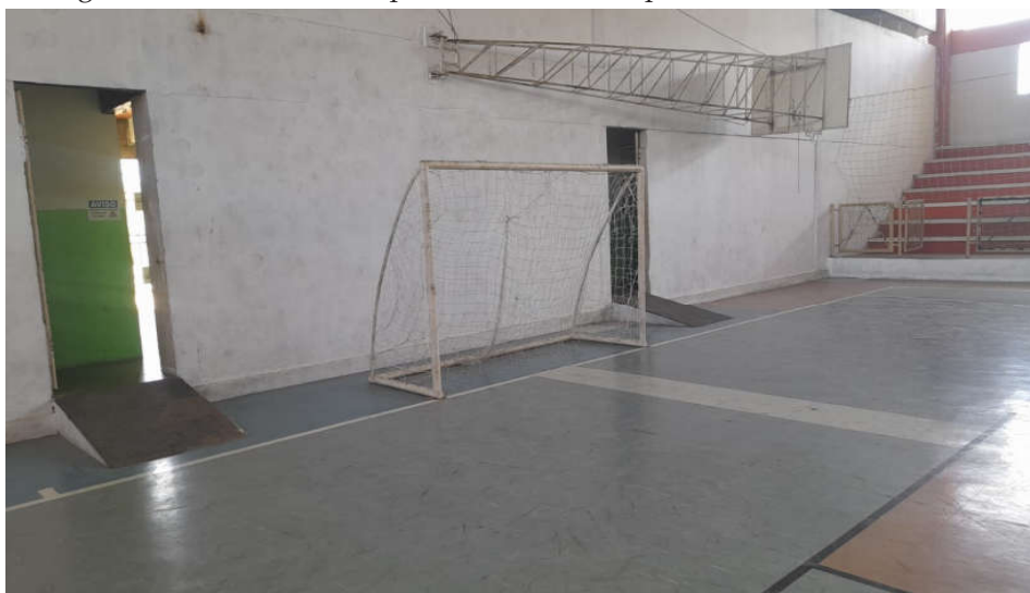
Figura 64: Portas com rampa do Ginásio de Esportes Paulo Santos Gomes
