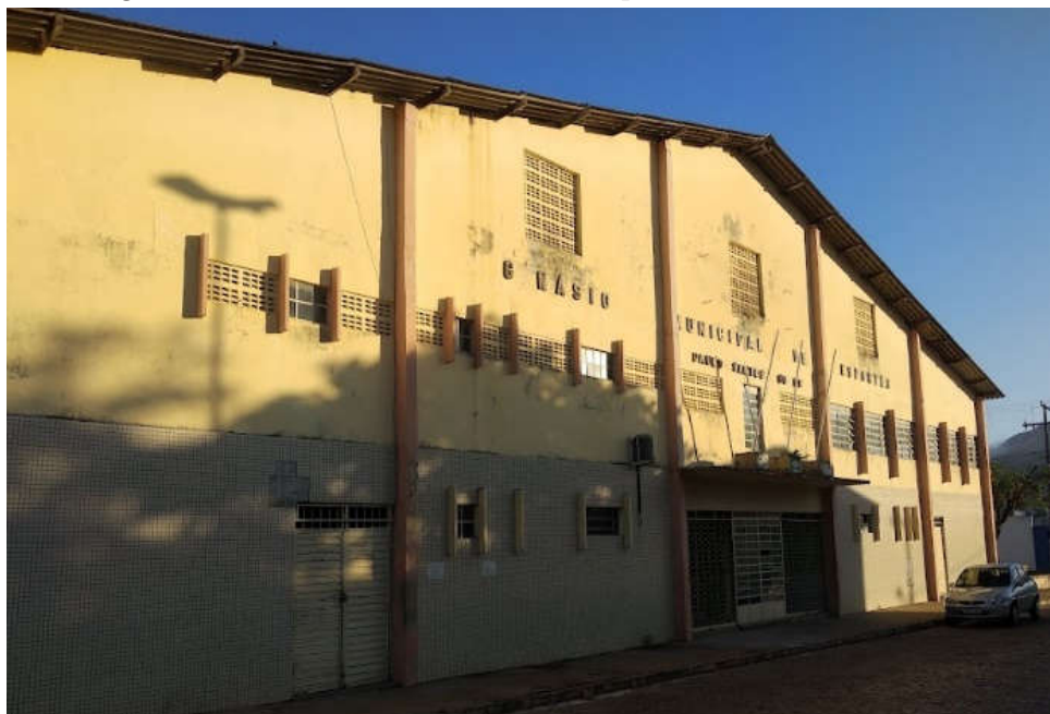
Figura 62: Vista externa do Ginásio de Esportes Paulo Santos Gomes
