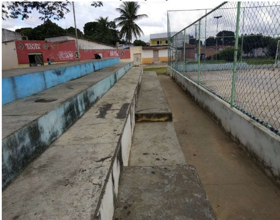
Figura 17: Arquibancada da quadra poliesportiva do Bairro Jacobina IV
