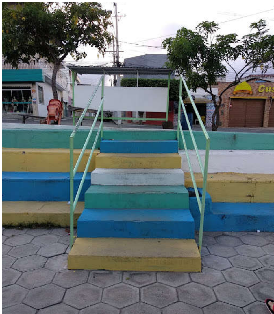
Figura 23: Escada de acesso 1 da quadra poliesportiva do centro
