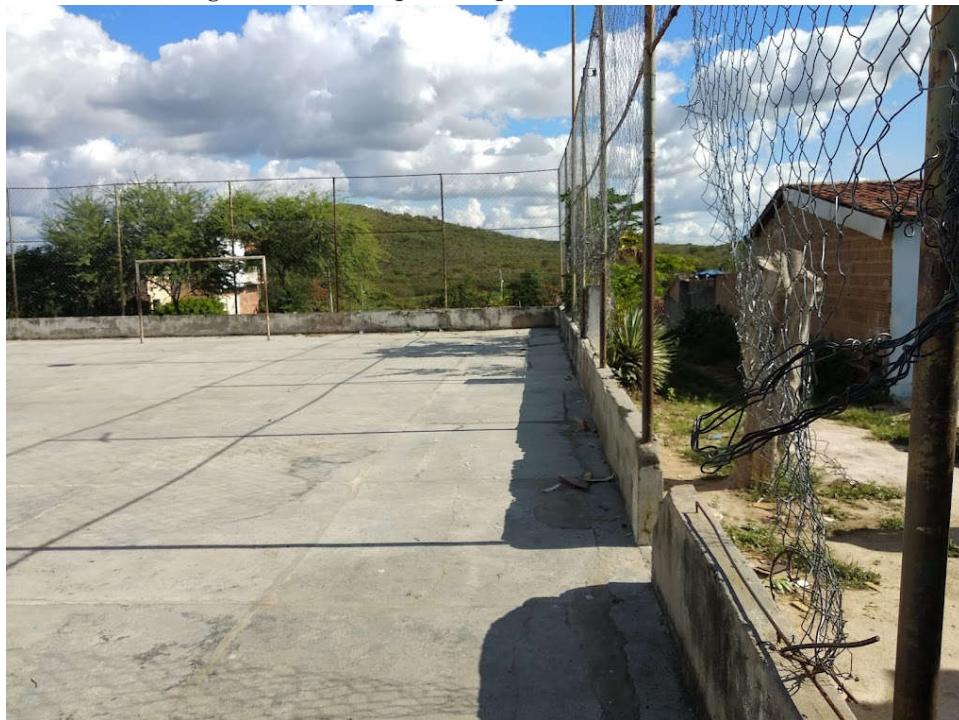
Figura 34: Telas e piso da quadra do bairro Mutirão
