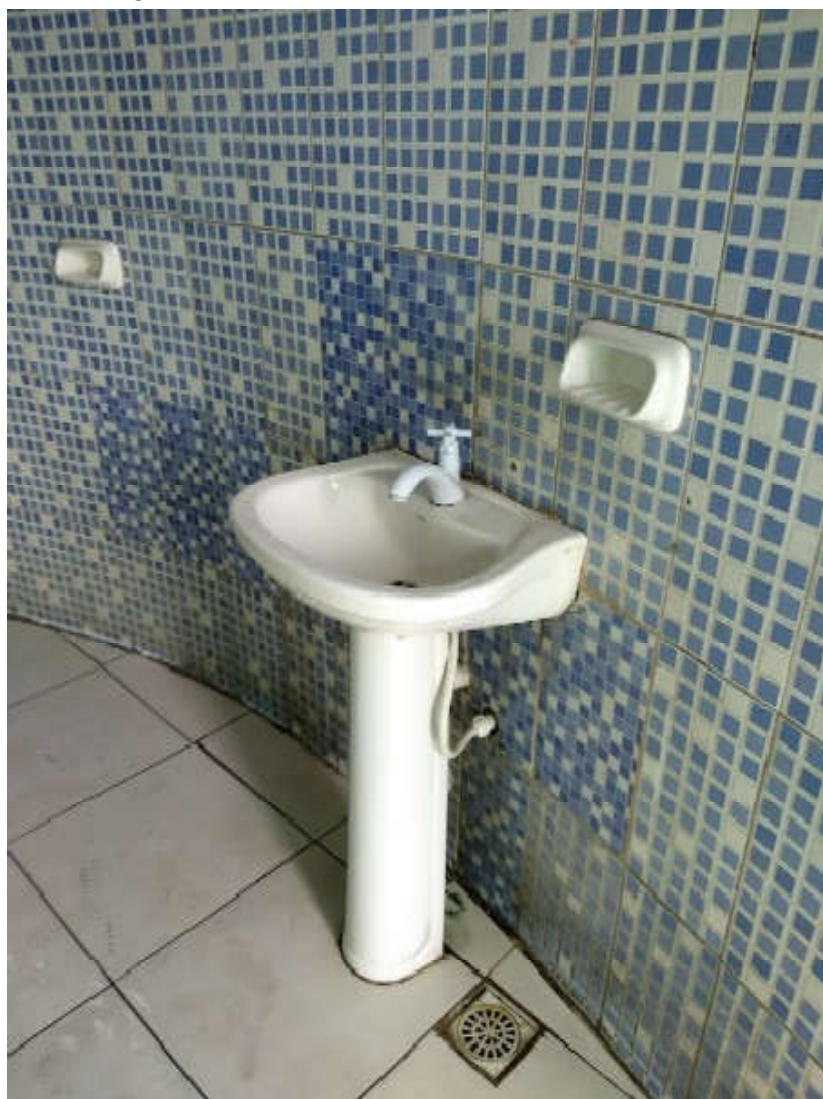
Figura 27: Lavatório do banheiro feminino do centro
