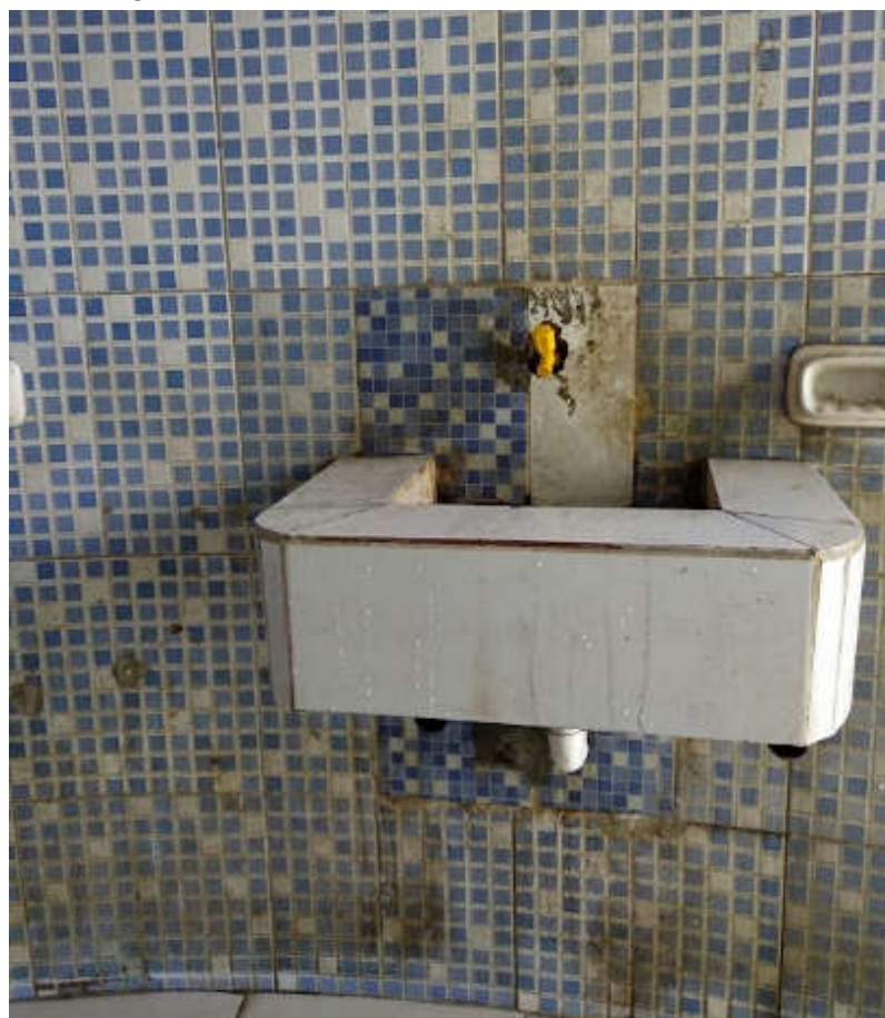
Figura 29: lavatório do banheiro masculino do centro
