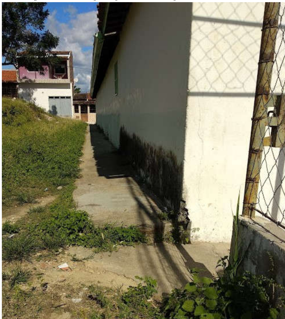
Figura 31: Passeio principal de acesso à quadra do bairro Mutirão
