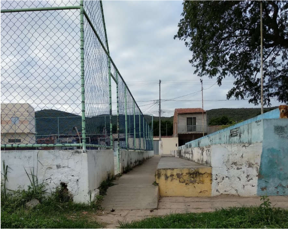
Figura 18: Rampa de acesso da quadra poliesportiva do Bairro Jacobina IV
