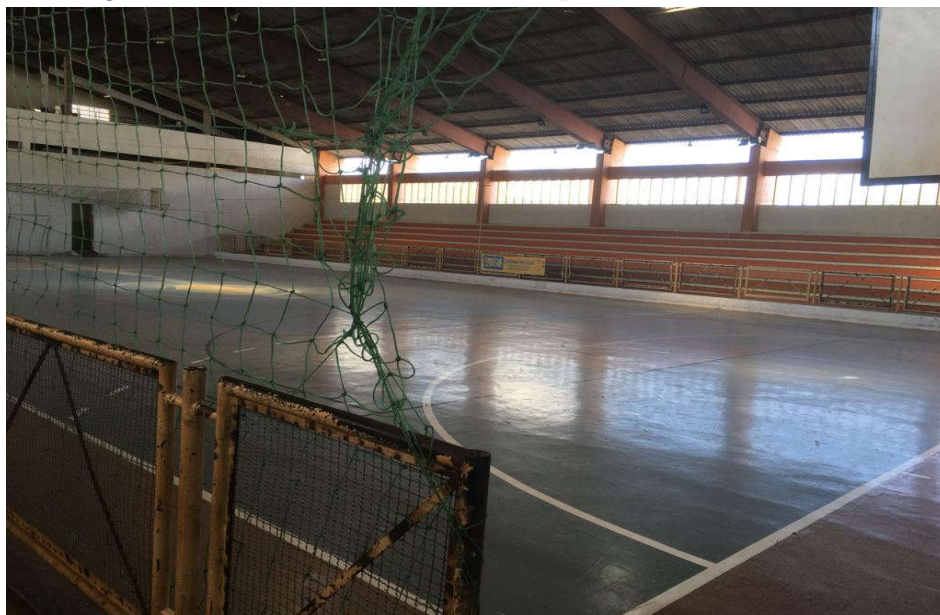
Figura 63: Vista interna do Ginásio de Esportes Paulo Santos Gomes
