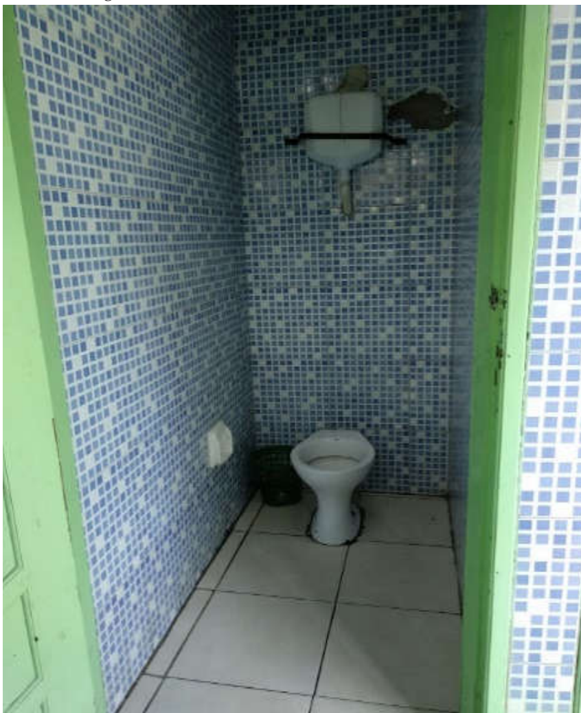
Figura 26: Sanitário do banheiro feminino do centro
